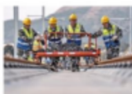
清流县云石大桥开始施工
