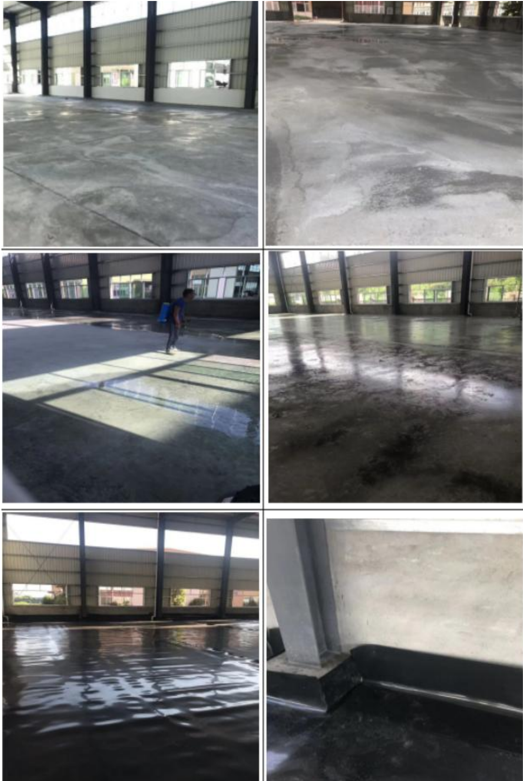
图 8.4-1 贮存库防渗工程施工图
