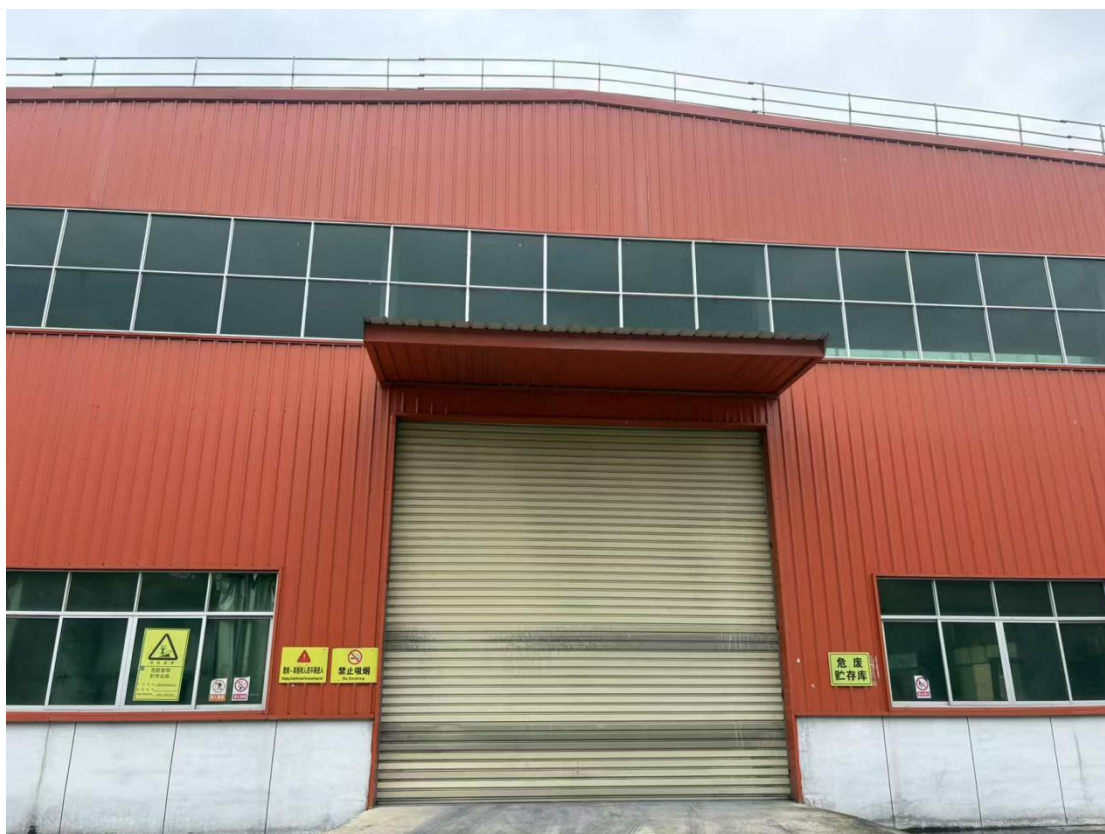
图 8.4-2 危废贮存库外景
