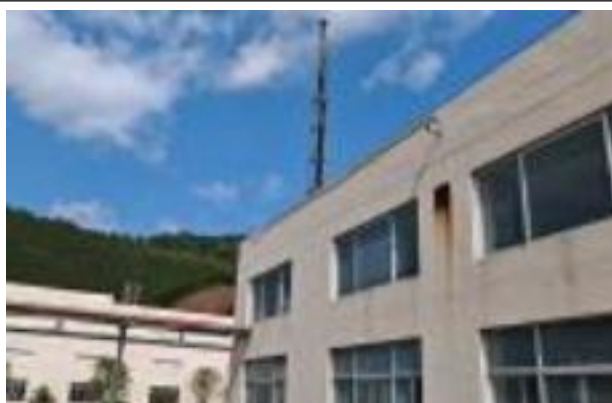
AHF 储罐呼吸废气治理装置 15m 排气筒 DA004
