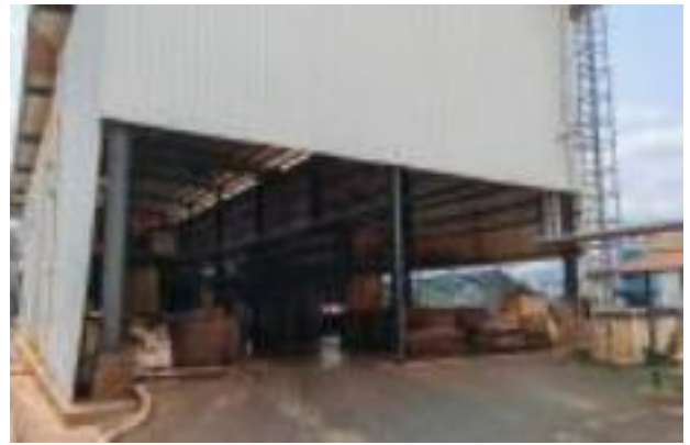
污水处理装置污泥压滤机与一般工业固体废物堆场 DS001
