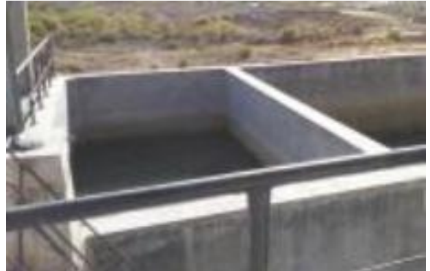
60m³ 初期雨水地下池
