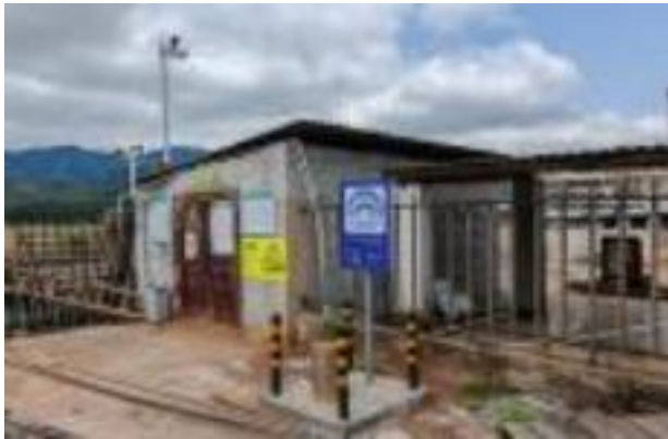
危险废物贮存库 DS001 与地下水监控井
