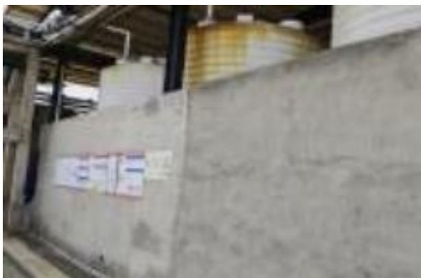
有水酸罐区及围堰
