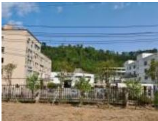
厂区东南侧（辉润石化）
