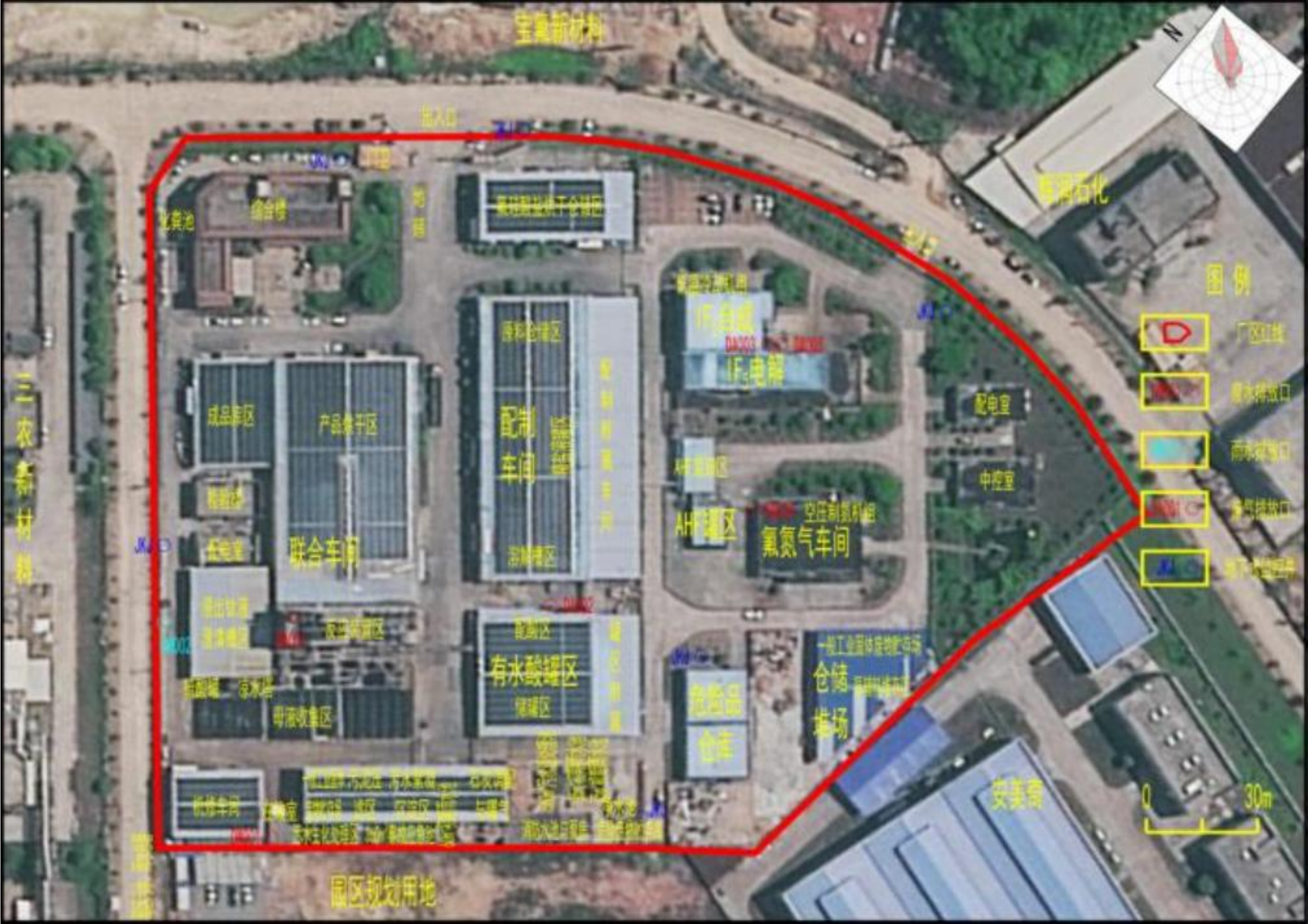
图 2.2.1-2 金氟化工现有工程建设现状图
