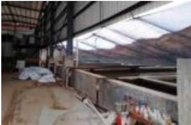
污水站 A2/O+斜管沉淀装置
