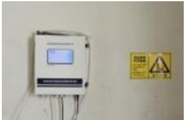
污水在线监控装置与危险废物贮存点标识
