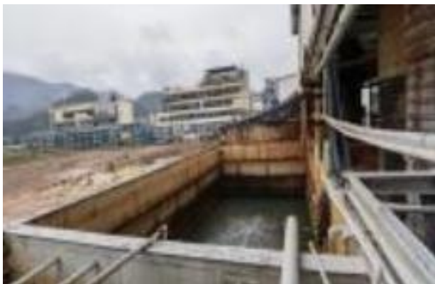
360m³ 事故废水地下池
