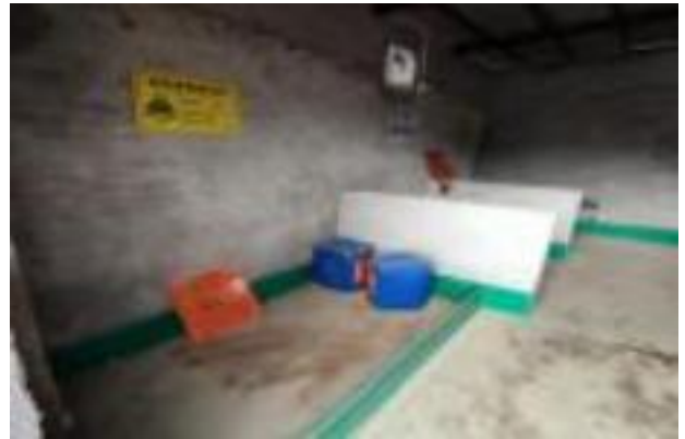
危险废物贮存库内部
