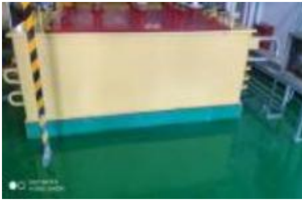
电解槽离地架设与地面防腐
