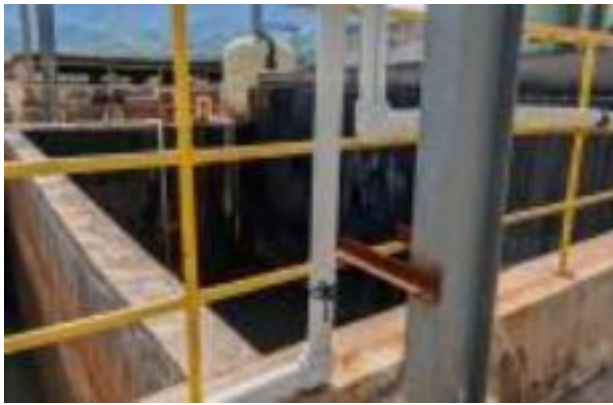
125m³ 事故废水地下池
