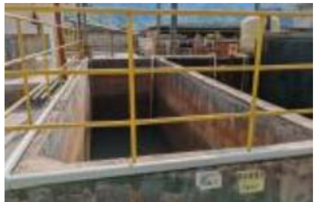
75m³ 初期雨水地下池
