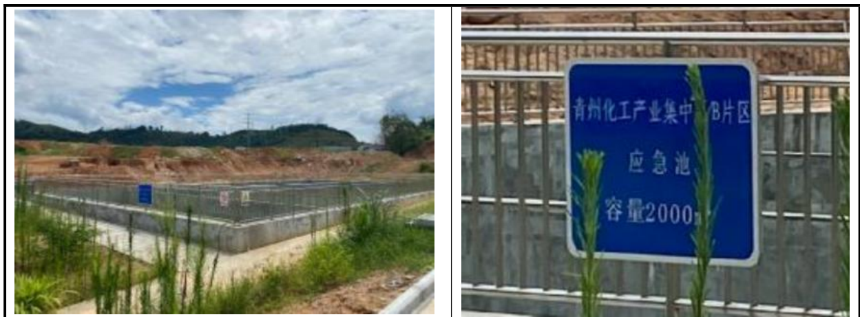
图 4.6-1 园区应急池照片
