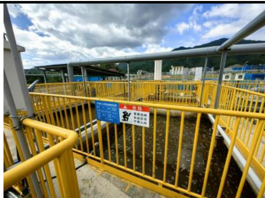
新厂区生活污水处理站(生化池)
