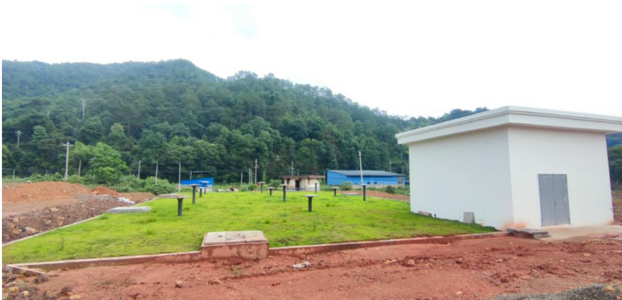
图 6.7-6 大路口片区新事故应急池现状照片
