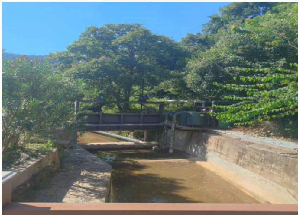
老厂区原有河道拦截闸
