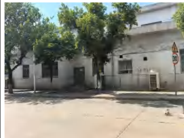
二炼钢新建 LF 炉冷却水系统现状
