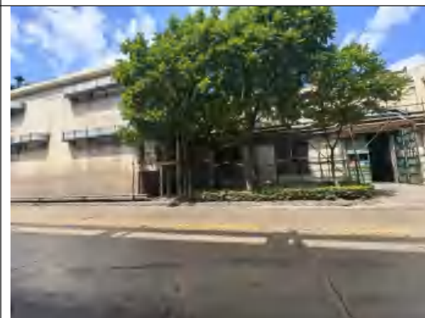
一炼钢利旧冷却水系统现状
