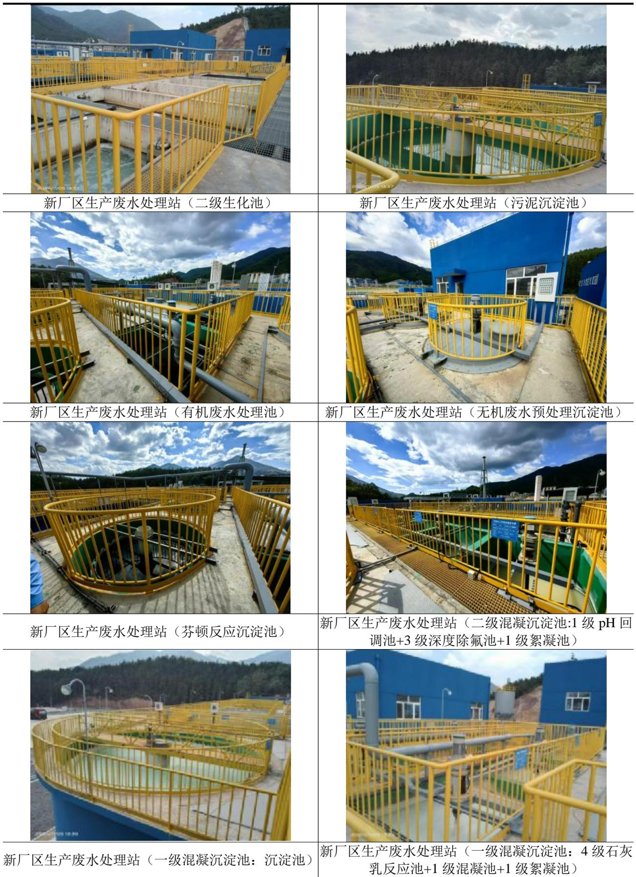
图 2.4-6 已建工程主要废水治理设施现状照片
