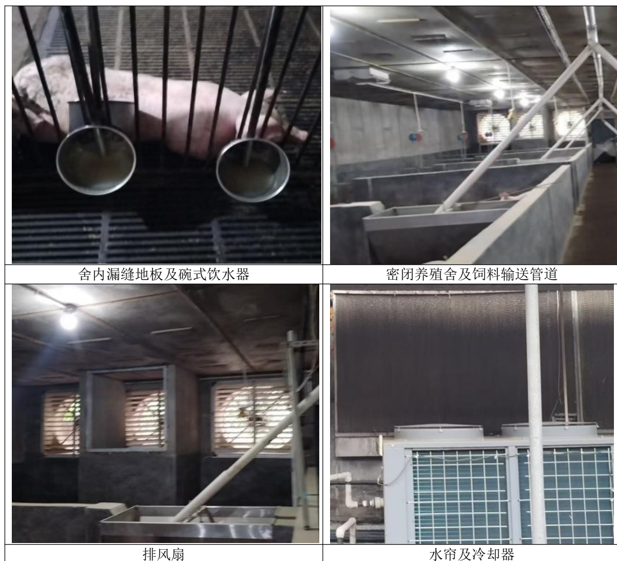
图 2.1-2 厂区现状建设情况图
