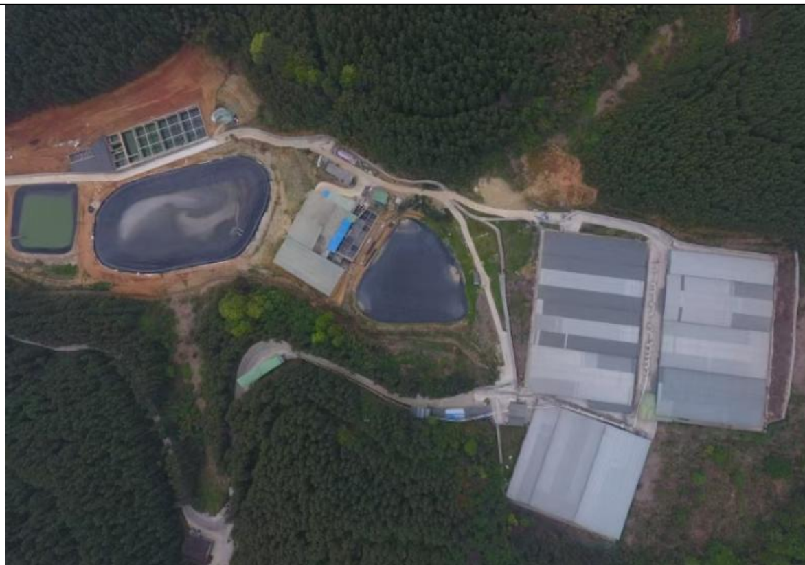
现状养殖场全貌
